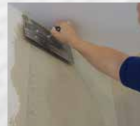
5. Feinspachteln und fertigstellen, z.B. Tapezieren
